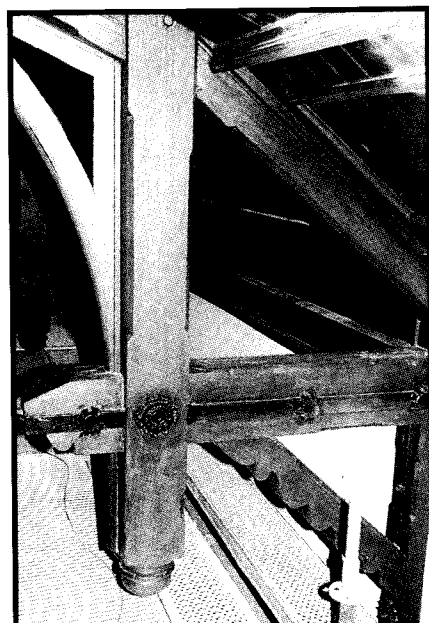
Holzstützen im Deckenbereich des Rathaussaales nach der Reinigung.
